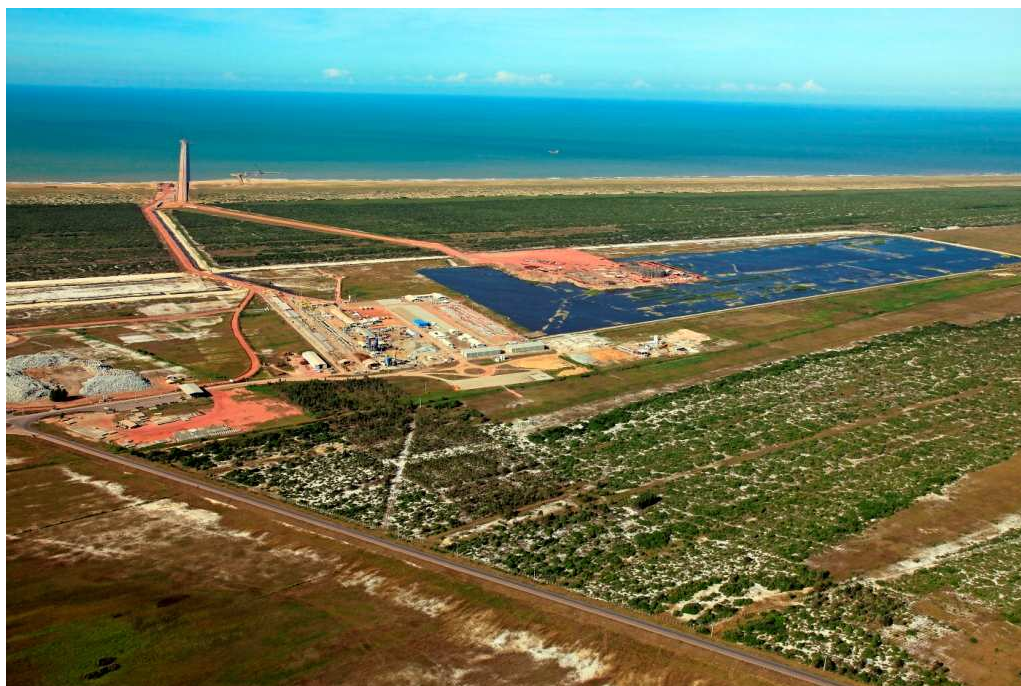
Figura 4: Visão geral das obras do Superporto (créditos: Victor Aquino, 2010).
